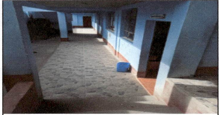
Foto 2: sustitucion de pasillo en el primer nivel
