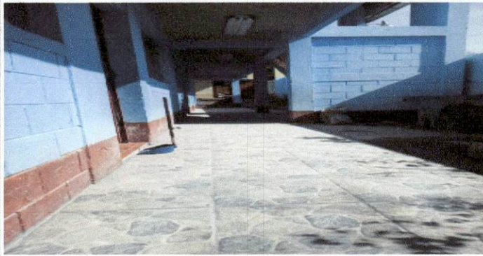
Foto 1: sustitucion de pasillo en el primer nivel
