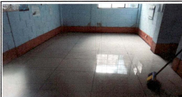
Foto1: sustitucion de piso en la dirección
