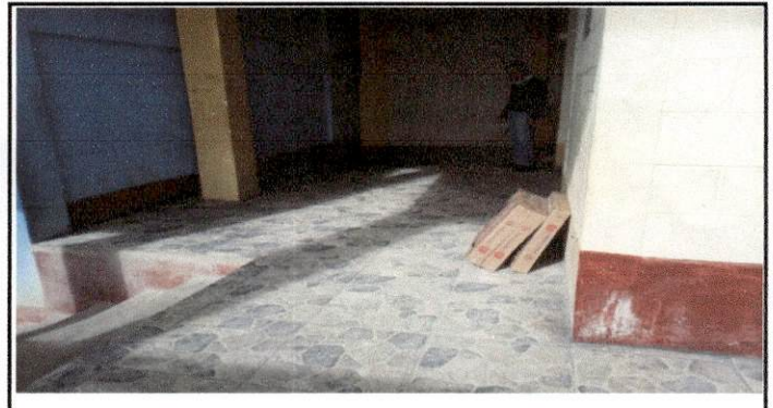
Foto 4: sustitucion de piso en patio frente a los servicios sanitarios
