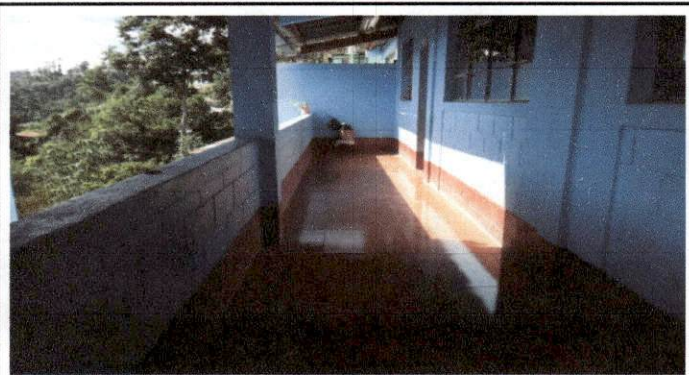
Foto 3: sustitucion de pasillo en el segundo nivel
