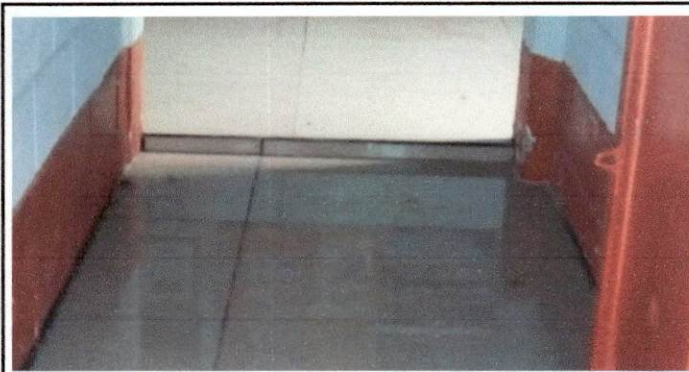
Foto 2: sustitucion de piso en la dirección
